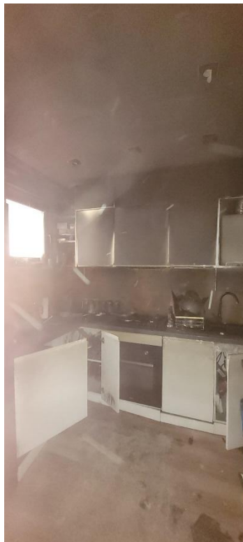
Kuchnia – meble do usunięcia, nowe tynki i instalacje
